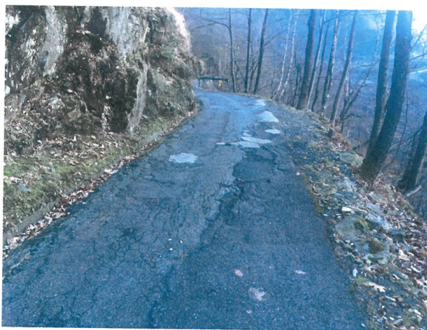
Stato di degrado dell'attuale pavimentazione
