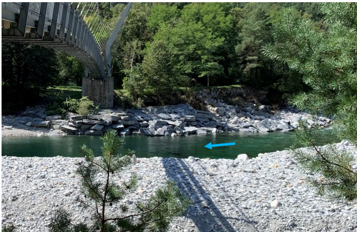
Figura 3: Vista dell'arginatura esistente in corrispondenza della pila destra della passerella (immagine del 30.08.2021)
