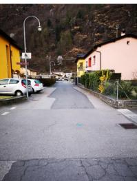
Lo stato attuale della pavimentazione impone il suo risanamento e, considerati i lavori di pavimentazione, si intende approfittare per sistemare ed ammodernare le infrastrutture comunali (rifacimento acquedotto comunale, risanamento canalizzazione e adeguamento illuminazione pubblica).
