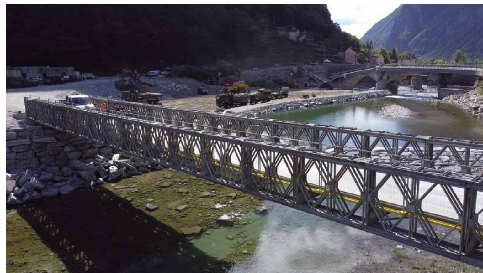
Il ponte provvisorio di Visletto posato dall'Esercito
