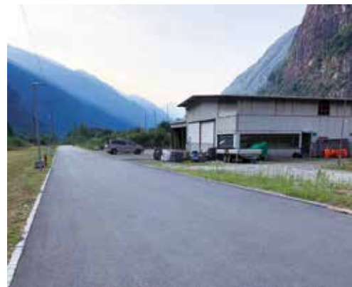
sopra Nuove infrastrutture a Riveo
