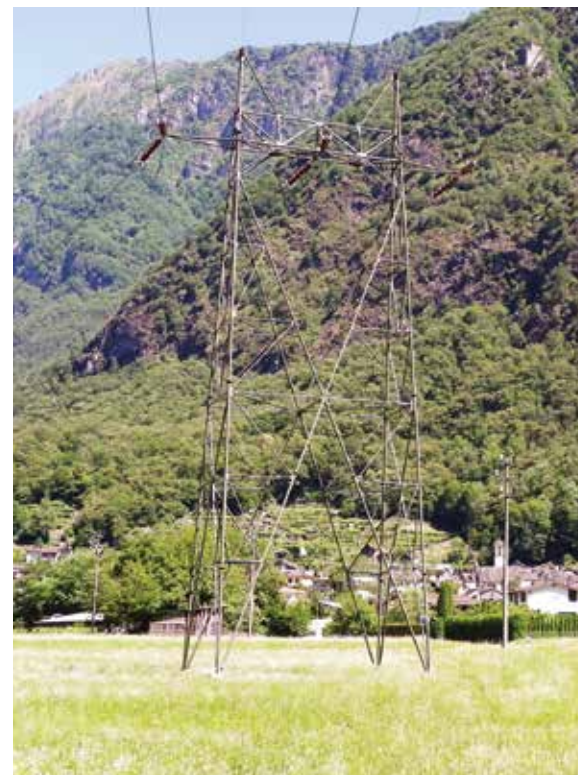
sopra Elettrodotti a Coglio
