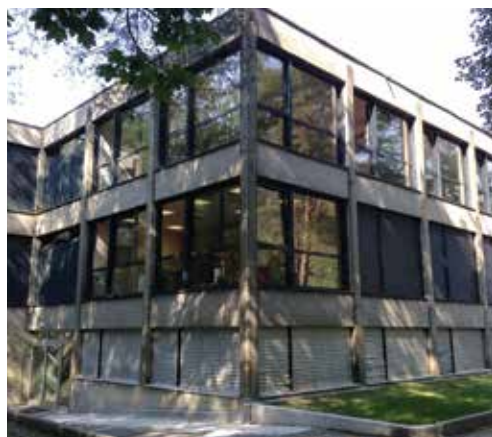
a sinistra Centro scolastico dei Ronchini: sostituzione di serramenti, vetri e tapparelle al PT e al 1P; al -1, l'operazione avverrà nel corso dell'autunno
