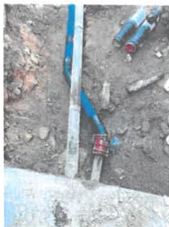
Foto ripristino tubo AP
