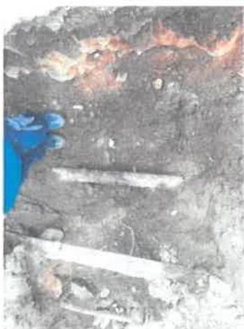
Foto situazione tubo esistente
